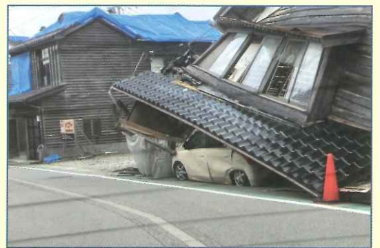
志賀町北西部の富来（とぎ）地区では、大きく損壊した家屋が多数見受けられました
