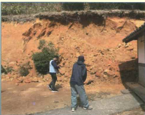
土砂崩れにより納屋が損壊した住民から聞き取り調査を実施しているようす
